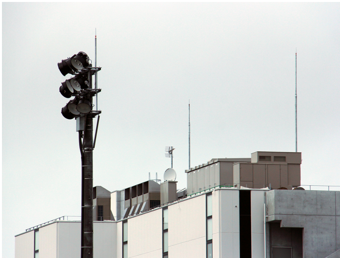
写真1 通常の避雷針（管理棟兼津波避難施設屋上） 多賀多目的運動場（サッカー場）の施設
